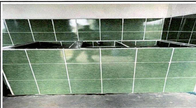
Foto1: Reparación y sustitución de la pila y área de la misma
