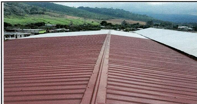
Foto 6: Pintura de lamina de tres salones de clase
