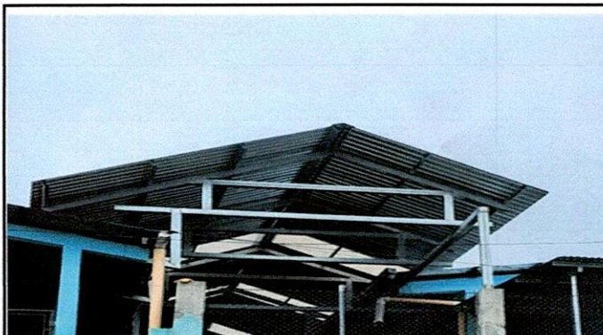
Foto 4: Mejoramiento de estructura metálica y cubierta de lamina del techo del patio
